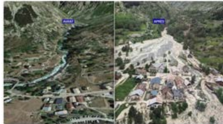
Le hameau de la Bérarde (Isère) avant et après les crues du 20 juin 2024 © BFM TV
